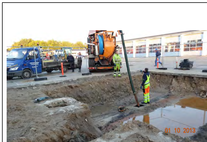
Billede 4 Tanke tømmes for olie, vand og olieforurenet sand
